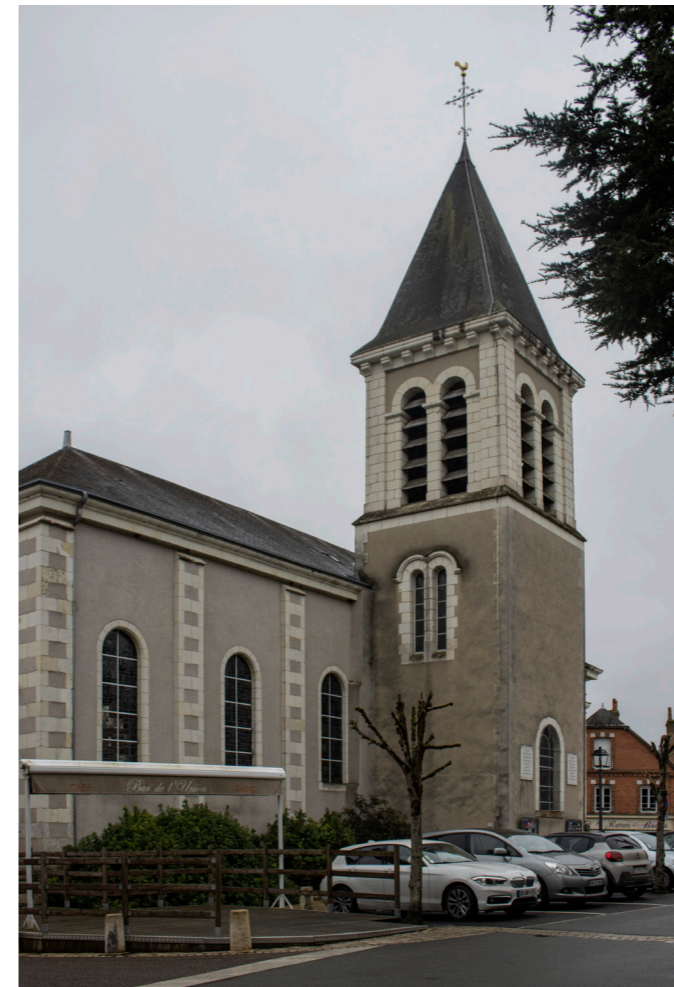
Photographie 39. Eglise de Neung-sur-Beuvron
